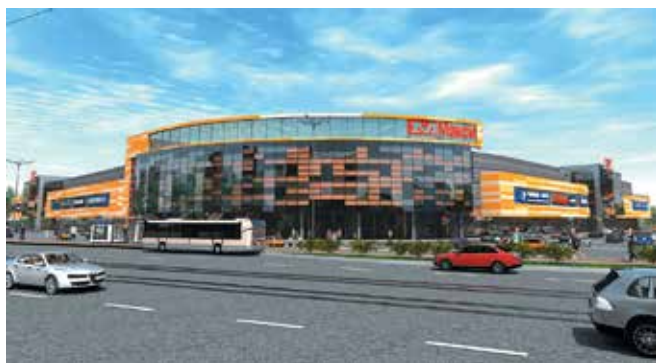
Строящийся ТРЦ «Макси» в Смоленске. Общая площадь – 63 750 кв. м.
