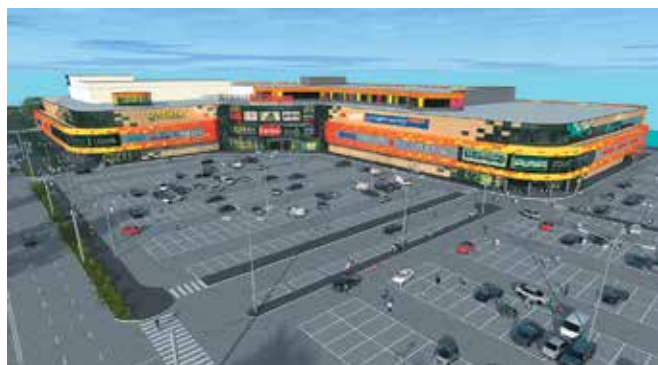
Строящийся ТРЦ «Макси» в Архангельске. Общая площадь – 71 350 кв. м.
