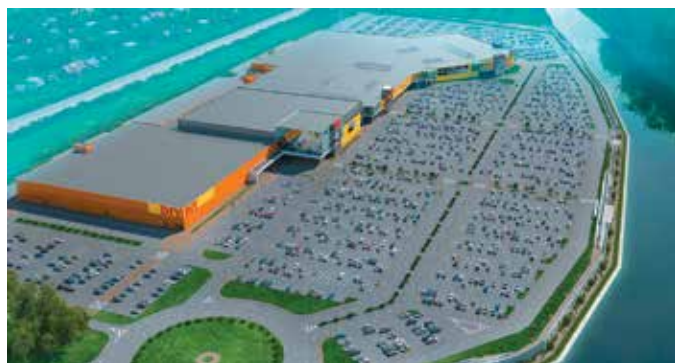
Строящийся ТРЦ «Макси» в Туле. Общая площадь – 105 350 кв. м.
